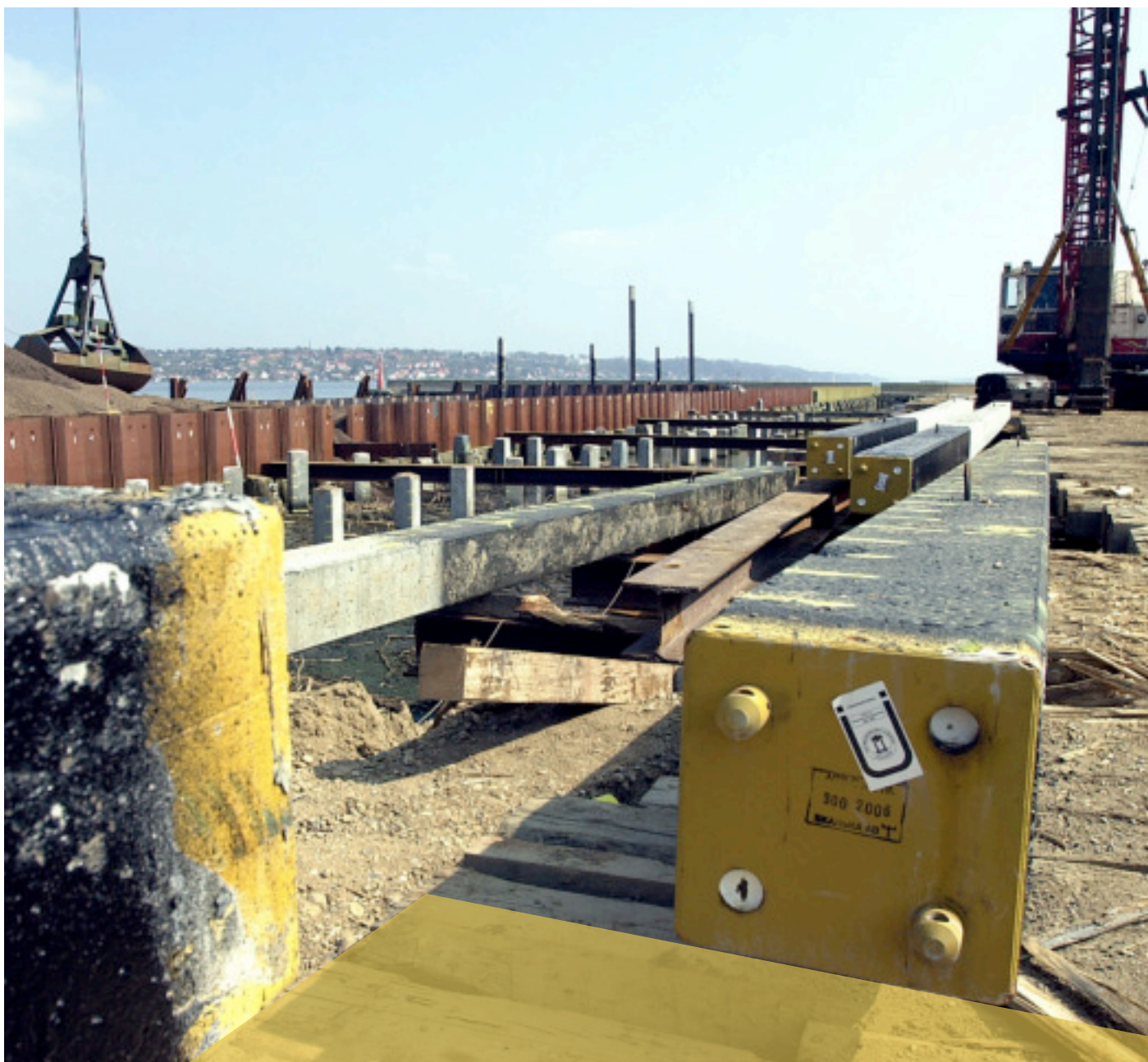
Opførelse af nyt kajanlæg på nordsiden af havnen, 2002.
